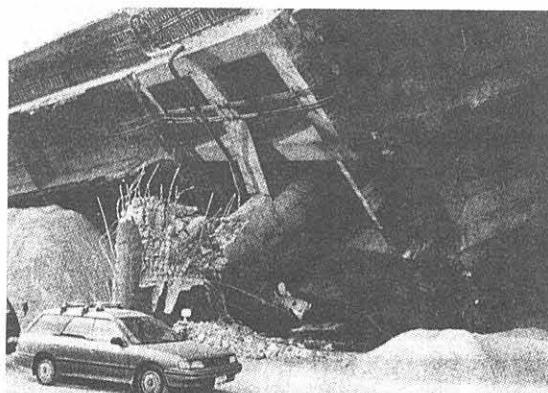
写真-1 ピルツ構造の倒壊（神戸市東灘区）
