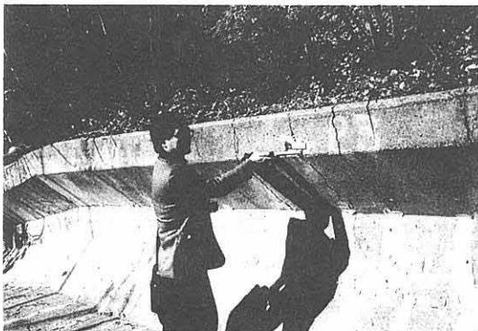
写真-9 震源地近くのアースダムの余水吐のひびわれ状況
