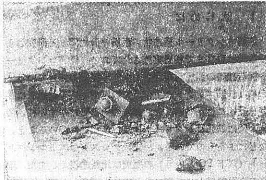
写真-2 PC 桁メタル支承の破壊
