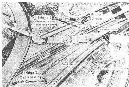
写真-3 インターチェンジにおける PC 橋の倒壊
