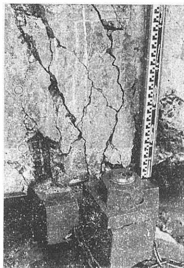
写真-1 PC 桁支承部コンクリートの損傷
