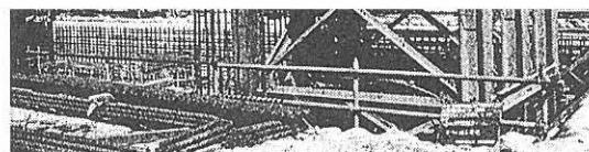
写真一 400×400 の H 形鋼を用いた門崎高架橋の SRC 橋脚における D 51 鉄筋の組立状況
