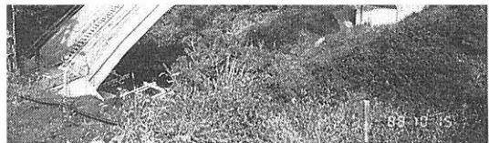
写真-3 角形鋼管アーチにコンクリートを充填して剛性を高めた後にこれをコンクリートで巻き立てている工事中の城址橋
