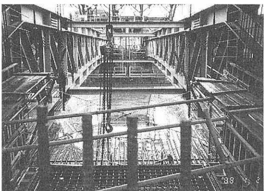
写真-2 支間中央部 70 m を閉合した状態の別府明礬橋の鋼トラス桁
