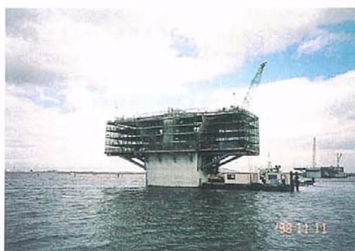
写真-7 木曽三川橋の柱頭部プレキャストセグメントの架設状況
