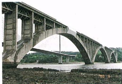
写真-5 ブルガステル(Plougastel)橋(道路鉄道併用橋として建設されたが、鉄道は敷設されなかった)
