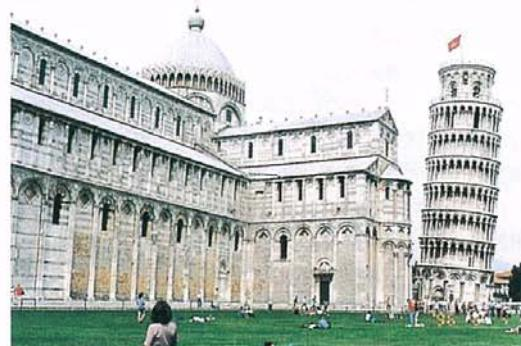
写真-4 ピサの斜塔 (Leaning Tower of Pisa)(Bonanno Pisano の設計で建設が開始された。高さ 56 m, 外径 15.5 m, 重量 14 500 トン)
